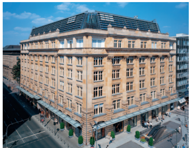
Die „Börsenstraße“ gehört zu Frankfurts Top-Adressen. Nach dem Umbau der Büroflächen wurde der Mietvertrag mit der unabhängigen Investmentbank Rothschild für zehn weitere Jahre verlängert.
